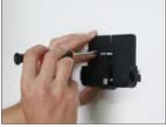
Ajuste la posición de la base de montaje y apriete los tornillos.
